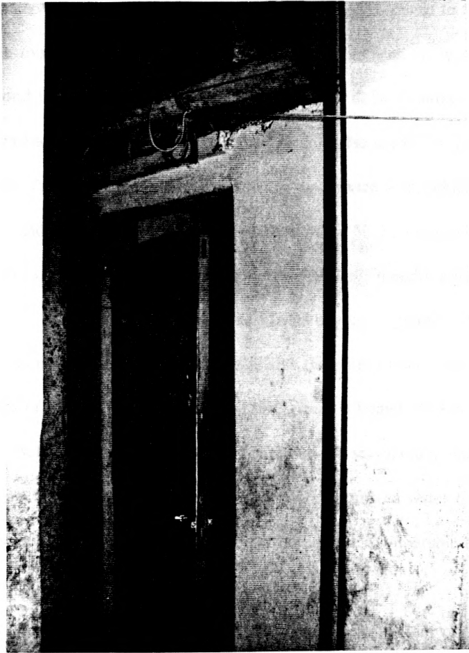
Fig. 4.17: HOME VI. Door to Service Core
