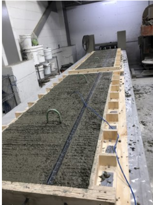
Figure 11: Panels after Pour
