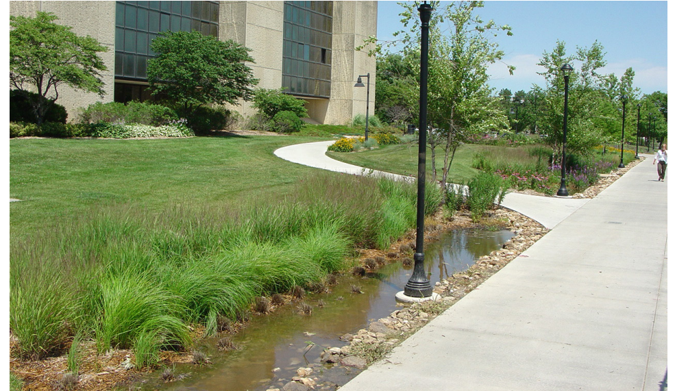
Fig. 3.32 A swale full of water (Skabelund 2017)
