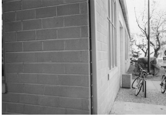
**FIG. 10 COMPRESSED STABILIZED SOIL BLOCK CONSTRUCTION**
